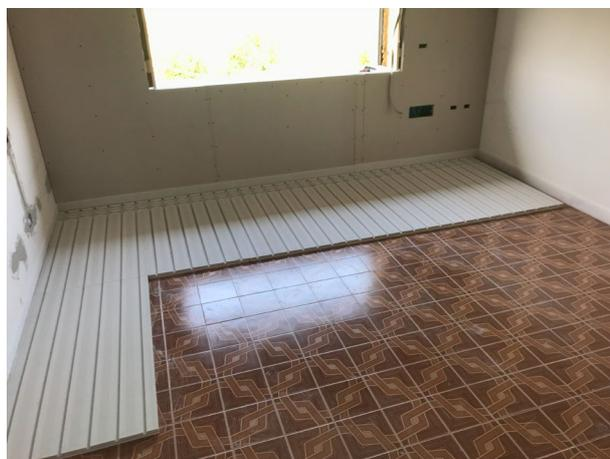
Posa delle lastre PaviGypso su pavimento esistente
