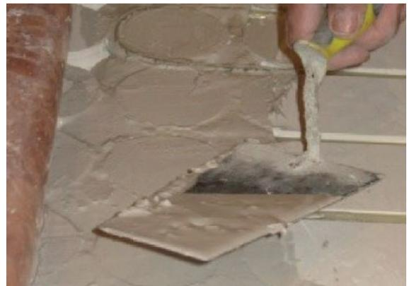
L'adesivo/rasante monocomponente MONOTACKGYPS è appositamente creato per l'applicazione su sottofondi a base anidrite senza l'uso di primer.
