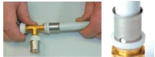
Completare la sigillatura a pressione utilizzando un dispositivo di pressatura o una pinza manuale.
