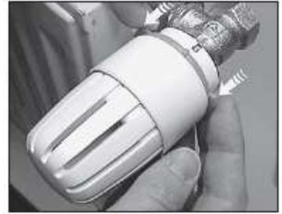
Ora l'anello di bloccaggio 3) è stato sbloccato e può essere spostato in direzione della valvola, rendendo così visibili sul volantino le indicazioni per la regolazione. Ora si può togliere l'utensile per sbloccare.
