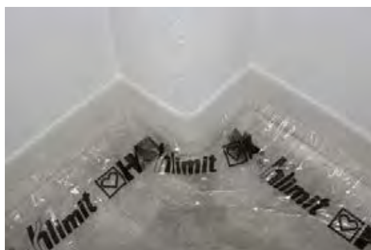
Figura 26 - Particolari della posa della fascia perimetrale isolante
