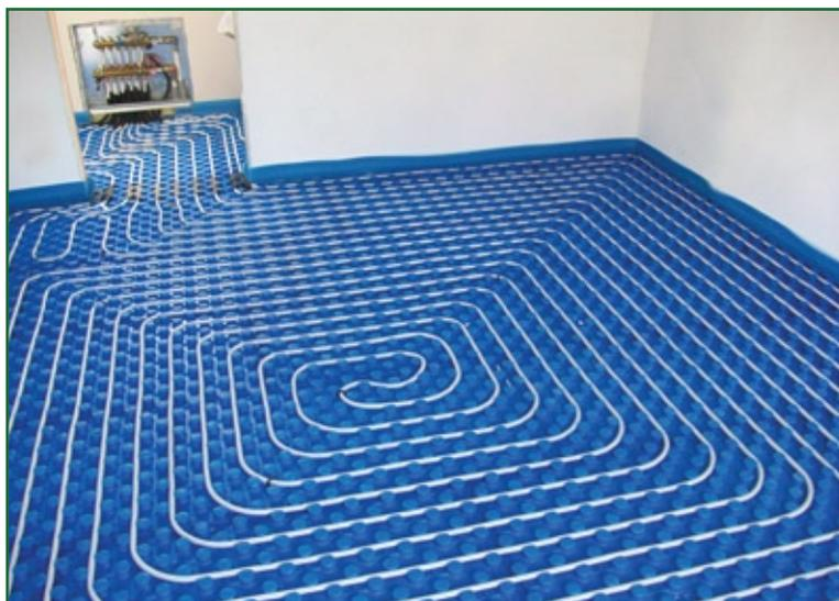
Generalmente utilizzato per immobili di nuova costruzione, l'impianto a pannelli radianti, ove possibile, risulta una soluzione ottimale anche in caso di ristrutturazione.
