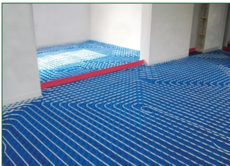
L'impianto di riscaldamento a pannelli radianti, molto più comunemente detto riscaldamento a pavimento è un sistema impiantistico ormai largamente diffuso ed apprezzato per il comfort che garantisce nonché per la praticità d'installazione.
