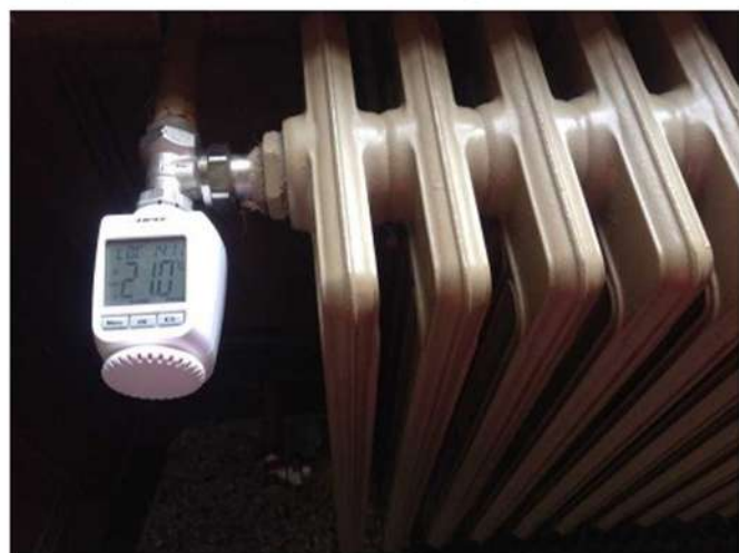
Installazione teste elettroniche cronotermostatiche Herz su radiatori esistenti
