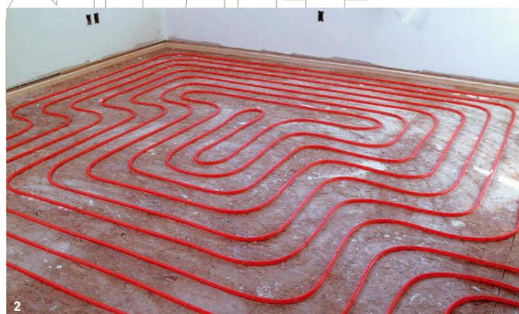
**1. GRANDI SUPERFICI.** Un tipico pavimento radiante per un ampio spazio in grado di effettuare il riscaldamento e il raffreddamento separati. L’ipotesi di realizzare una forma di “sistema a 4 tubi” per riscaldamento e raffreddamento simultanei, a parte considerazioni energetiche e di costo, andrebbe verificata con la disponibilità di programmi di calcolo per le particolari condizioni richieste. (Klimit)
