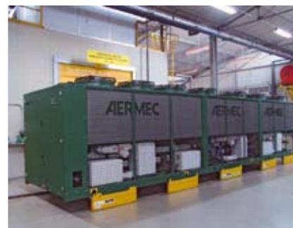
**LA CLIMATIZZAZIONE del Centre Court di Wimbledon, sede del famosissimo torneo di tennis, è assicurata da nove refrigeratori Aermec serie RV 3603E, versione extrasilenziata con compressori a vite e con gas refrigerante R407C.**
