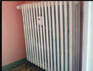
L'INSTALLAZIONE è conclusa: al radiatore sono stati installati la testa per regolare la temperatura e il ripartitore.
