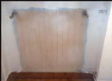
LA FASE di sostituzione della valvola e del detentore.
