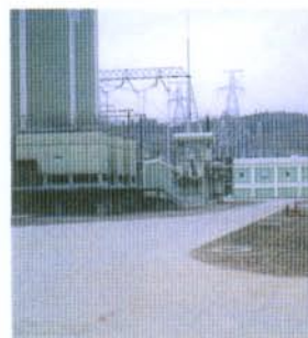
Per la diga delle Tre Gole, realizzata in Cina, verranno installati ventotto raffreddatori evaporativi prodotti dalla Decsa
