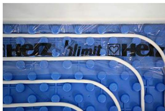
Figura 26 - Particolari della posa della fascia perimetrale isolante
