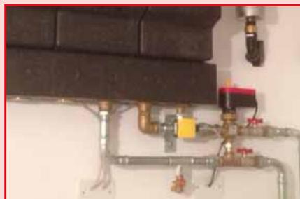
Installazione di un nuovo sistema radiante a pavimento di circa 300 m<sup>2</sup> presso una casa singola. Componenti principali dell'impianto: caldaia per la sola alimentazione del circuito riscaldante, accumulo da 1000 l con serpentino sanitario ed integrazione impianto solare termico (sup. 13,8 m<sup>2</sup>). Installati inoltre un **regolatore climatico con valvola miscelatrice Herz** e tre **Herz Pumpfix Direct**.
